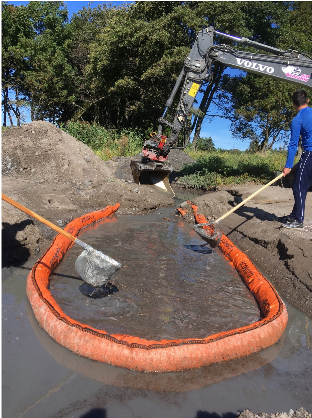
Figur 22. Opptak av pellets ved hjelp av hov.
