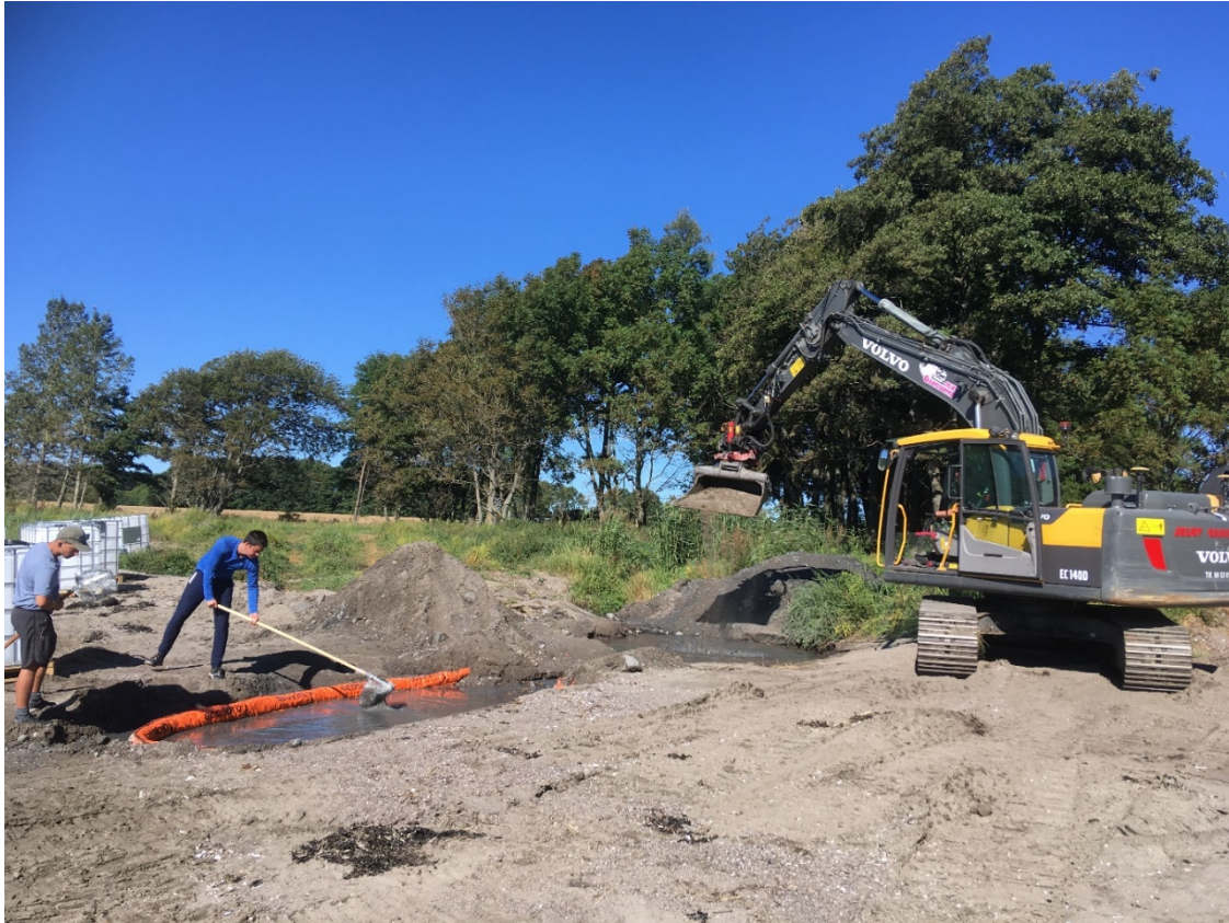
Figur 21. Dam for å fange pellets på Reierstranda i Østfold.
