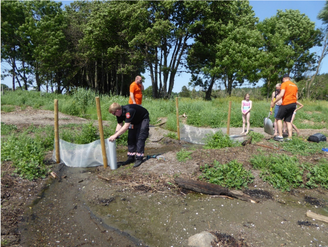
Figur 19. Oppdemming av bekk for fangst av pellets.
